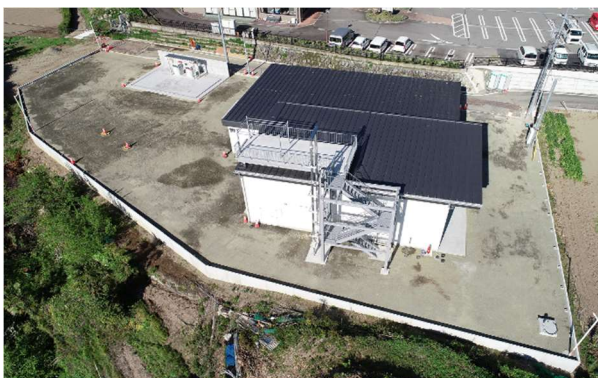
庁舎を南西側から空撮
