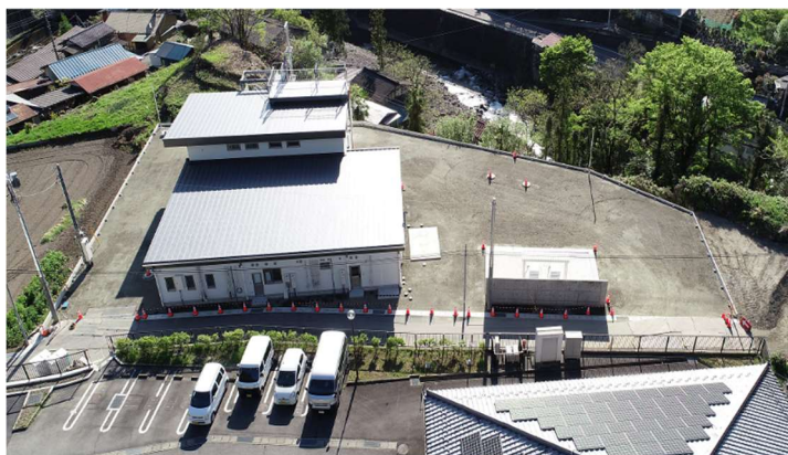
庁舎を西側から空撮
