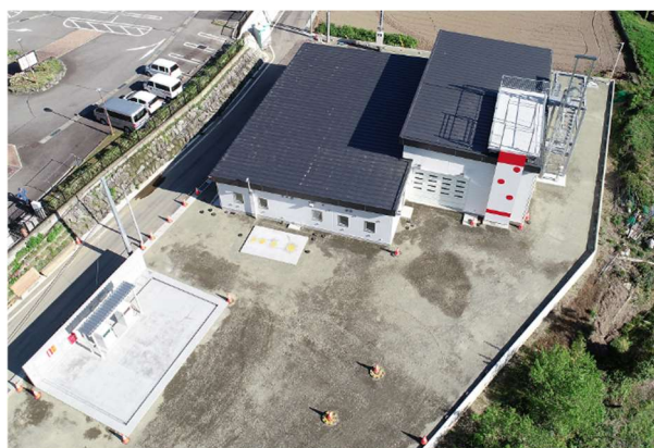
庁舎を北西側から空撮
