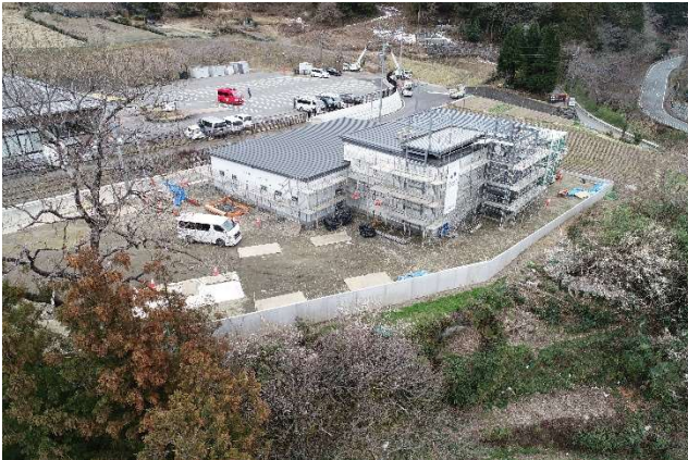
庁舎を北西側から空撮
