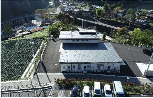
庁舎を東側から空撮
