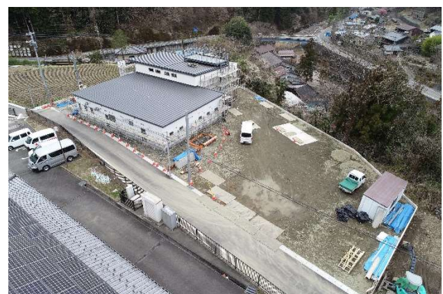
庁舎を北東側から空撮
