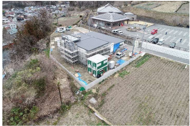
庁舎を南西側から空撮
