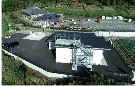
庁舎を西側から空撮
